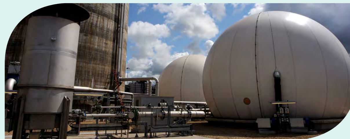
Northumbrian Water 位於 Howdon 的污泥處理中心。
