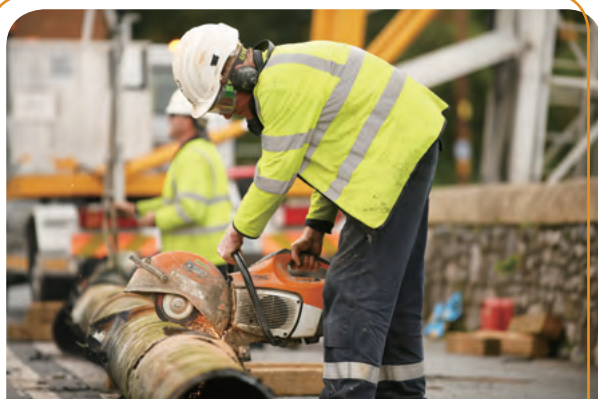
WWU 的員工正在 Topsham 的 Clyst Bridge 上工作，為其燃氣管道升級項目的一環。
