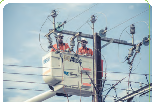
SA Power Networks 的技術人員進行架空電纜工程，確保供電安全。
