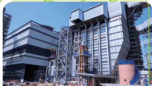
港燈的 L10 聯合循環燃氣發電機組。
