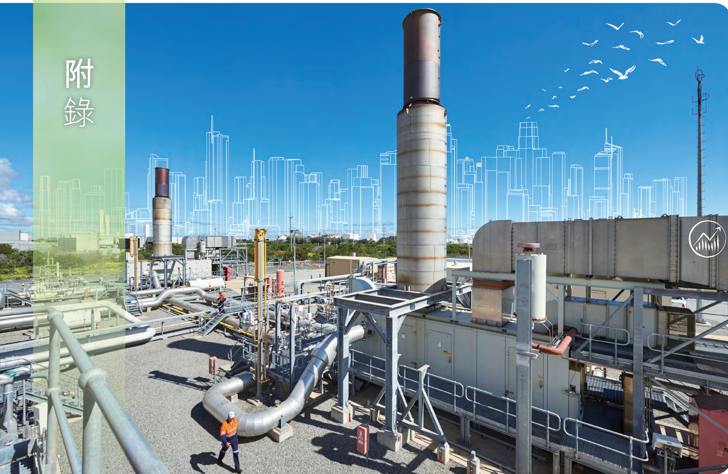
DBP 的天然氣壓縮機站。
