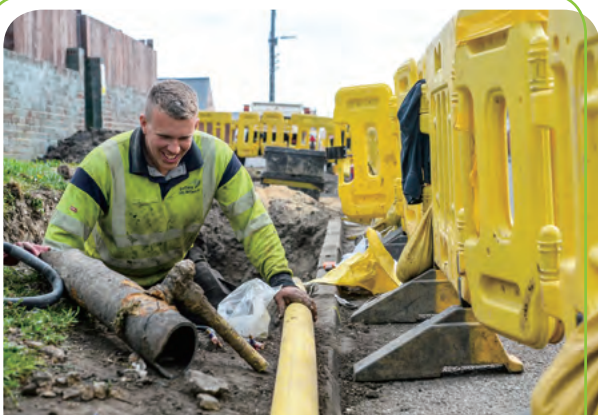
NGN 的英國桑德蘭(Sunderland)天然氣工程師以現代化的金屬管替換老化的金屬管。
