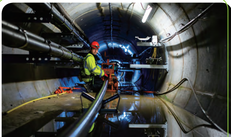
UKPN 的工程師於倫敦 Battersea 地下安裝新電纜。
