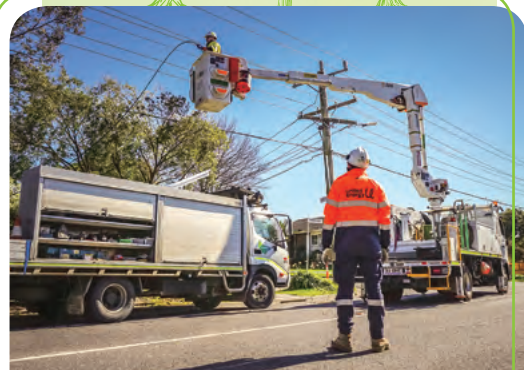
United Energy 工人進行路邊作業。系統性網絡維修以加強其可靠性。
