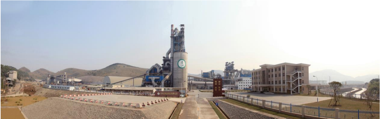
圖二： 長江基建旗下青洲英坭全資擁有的雲浮旗艦水泥廠現已全面投產，熟料產能每日四千五百公噸。
