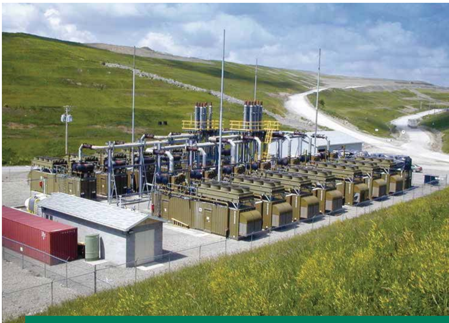
Energy Developments 的兩大業務範疇包括清潔能源(堆填區沼氣、煤礦廢氣、風力及太陽能)以及遠端能源。
