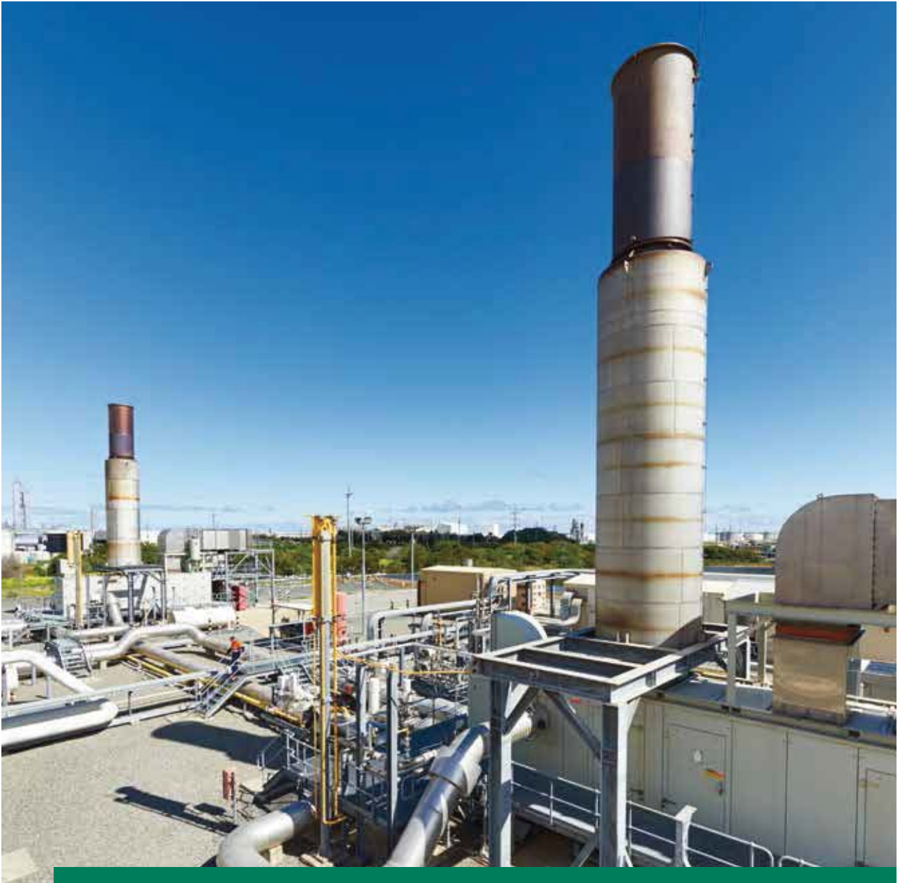
Dampier Bunbury Pipeline 乃西澳洲省主要的氣體輸送管道。
