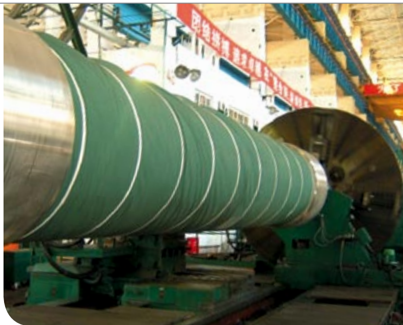
珠海發電廠現正擴建兩台六百兆瓦的發電機組（第三號及第四號機組），工程進展順利。
