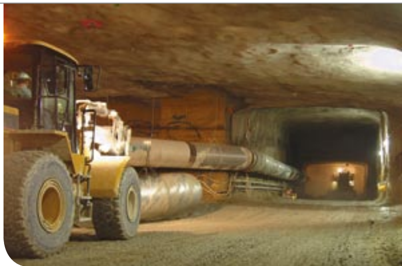
於澳洲悉尼市的 Lane Cove Tunnel 之興建工程進度良好。
