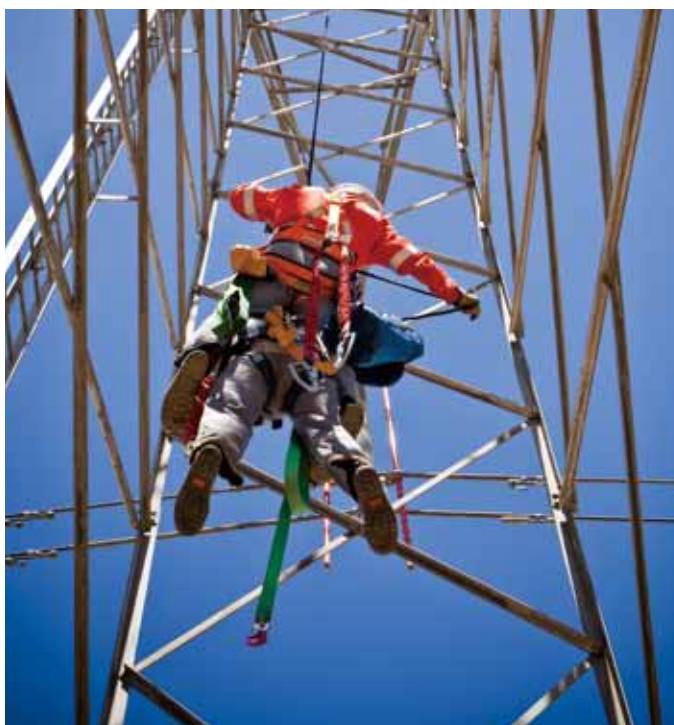
■ Spark Infrastructure 繼續為長江基建提供理想的現金分派。
