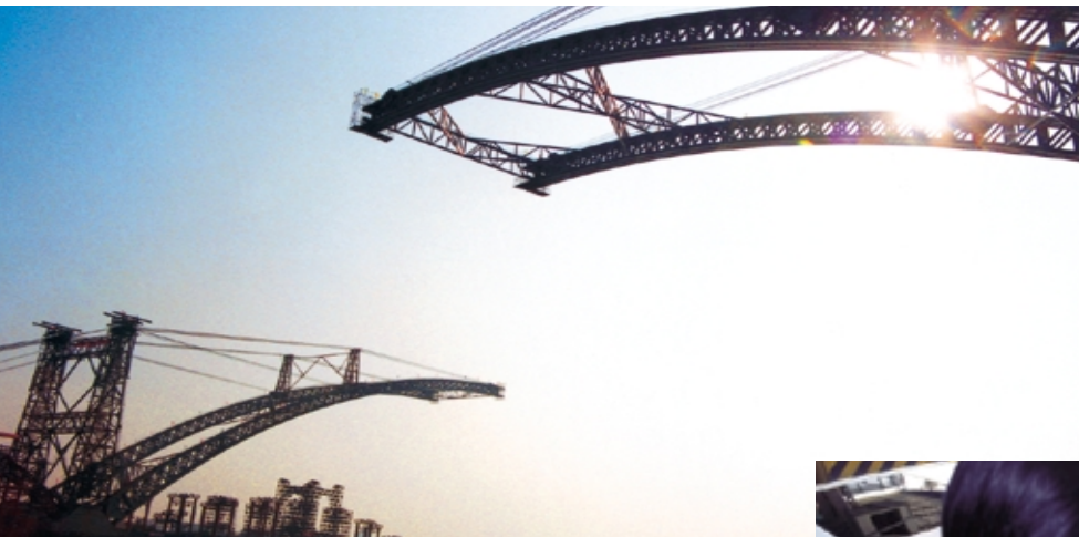
丫髻沙大橋的興建應用了一些最先進的工程及建築科技。
