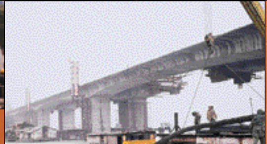
興建中的廣東省廣州東南環高速公路
