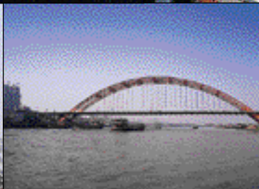
南海公路網之山西橋
